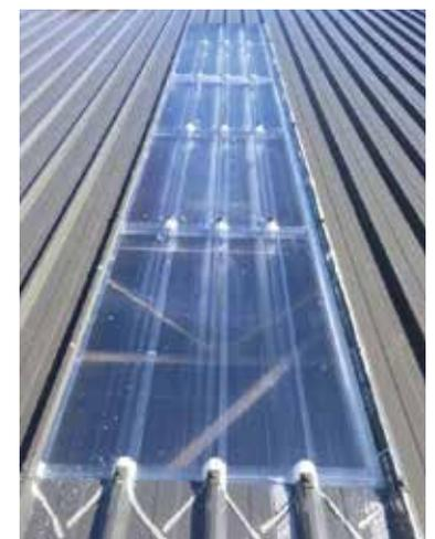
De même, mis à part les panneaux avec option Renforcé, chaque cloisir transversal des panneaux **ONDUCLAIR® THERMO** doit reposer sur une panne et être correctement fixé.
